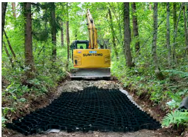
テラセルを用いた林道補修の様子
