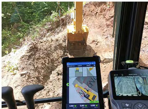
ICT建設機械による施工状況
