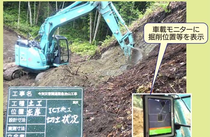
マシンガイダンスバックホウ※による掘削作業
