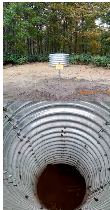
大型排水 さんさ 管を設置（上） ほかし肥料投入後（下）
