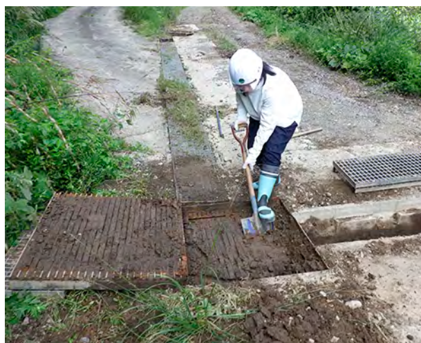
職員による排水溝の清掃の様子
