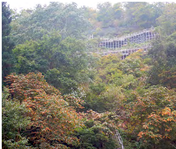
安全に施工するための作業足場
