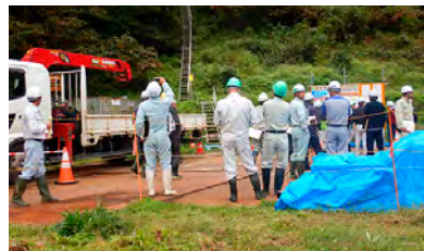
安全パトロールの様子
