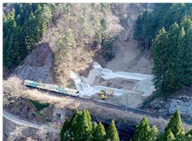
阿武隈急行と治山ダム工事現場
