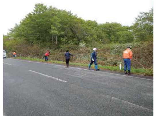
遭難防止看板設置ロープ張り
