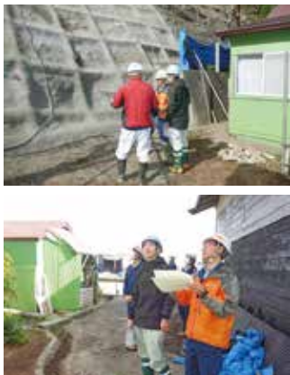
治山工事現場の見学
