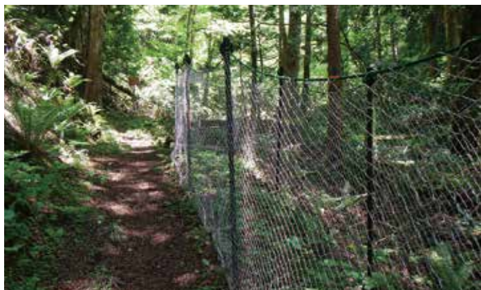
植生保護柵設置状況
