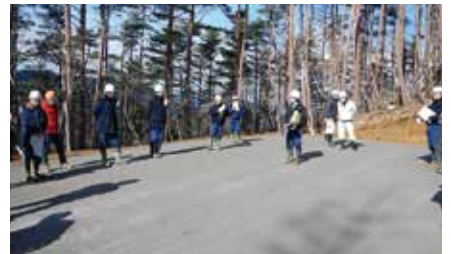
鉄鋼スラグ施工後の路面状況
