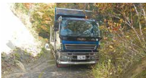
R=12 掘割では両側の草木や崩土が支障となる
