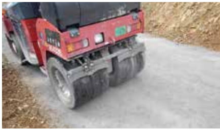
鉄鋼スラグ施工状況（ローラー転圧）
