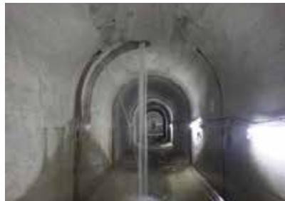
写真② 排水トンネル工の例
