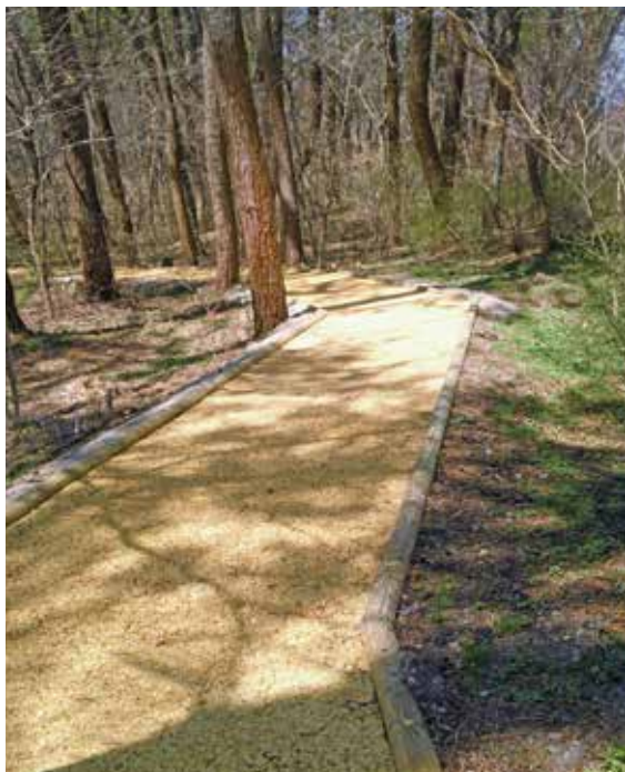
ウッドチップを敷き詰めた歩道
