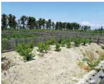
写真2：盛土を伴う海岸林造成
