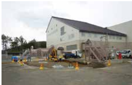
山葵沢地熱発電所
