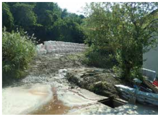
平成30年8月豪雨（山形県）の応急対策大型土のう設置
