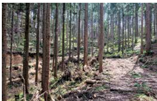
図4. 谷を横断する箇所が高くなった作業道
