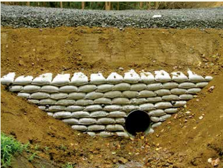
従来のコンクリート土のう積み工
