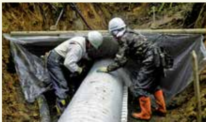
背面遮水シート貼付
