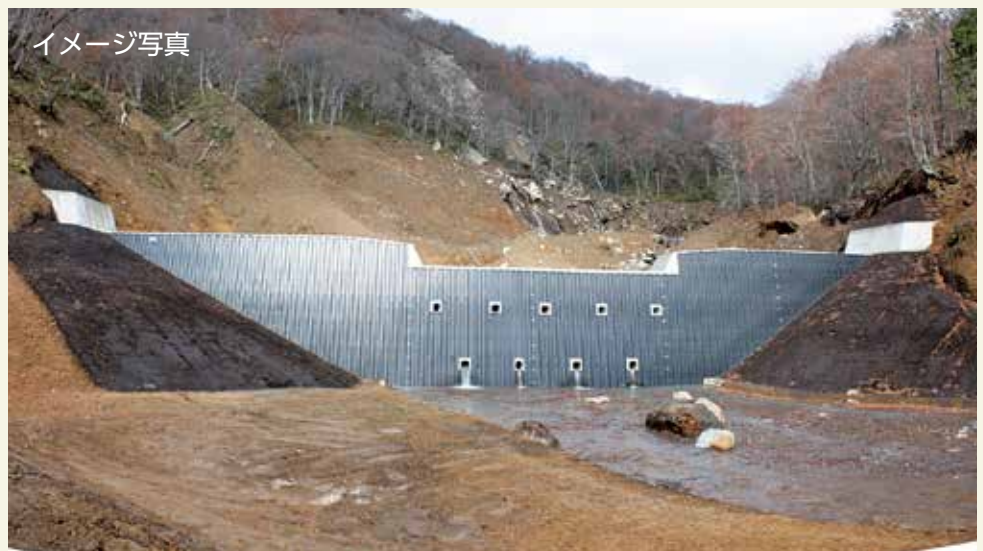
写真-⑥ 「ダブルウォール工法」のダム
