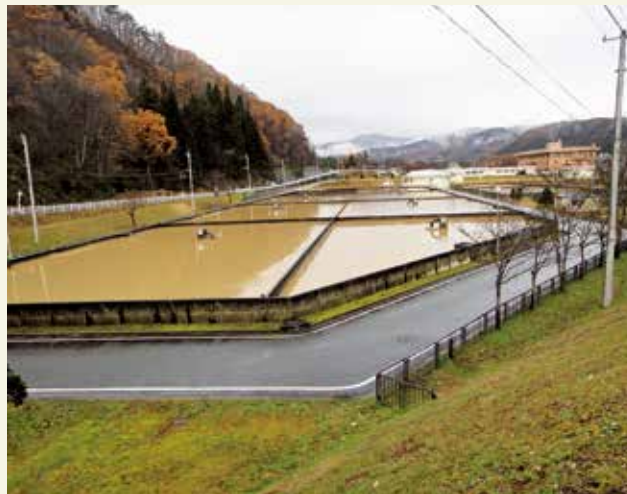
写真-② 濁水が流入した西川浄水場
