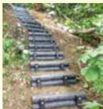
津軽峠の歩道整備
