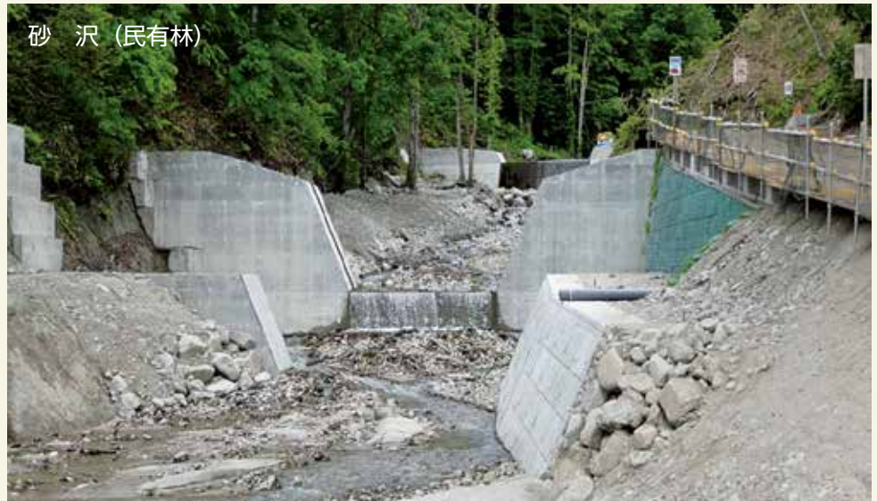
写真-⑤ 先に完成させた下流部の民有林内の治山ダム（山形県施工）
