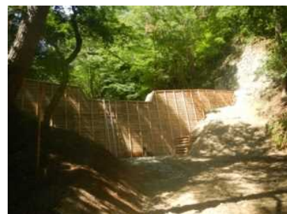
木製型枠を残した工法の治山ダム
