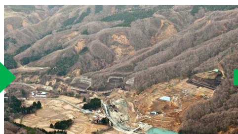
復旧工事施工中
