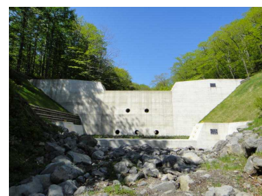
【熊沢治山工事（雫石町）】
