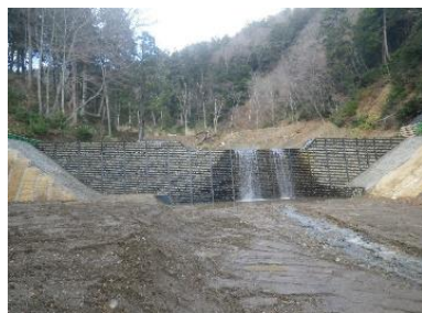
【鋼製枠床固工（外ヶ浜町）】
