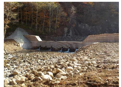
【治山ダム（八幡平市）】
