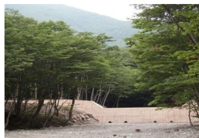
【木製残存型枠を使用した治山ダム（釜石市）】
