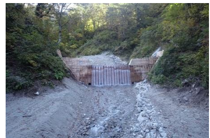
【砂沢木製型枠谷止工（西川町）】
