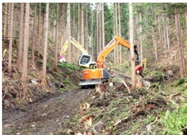
森林作業道作設・集造材 (大槌・気仙川森林計画区)
