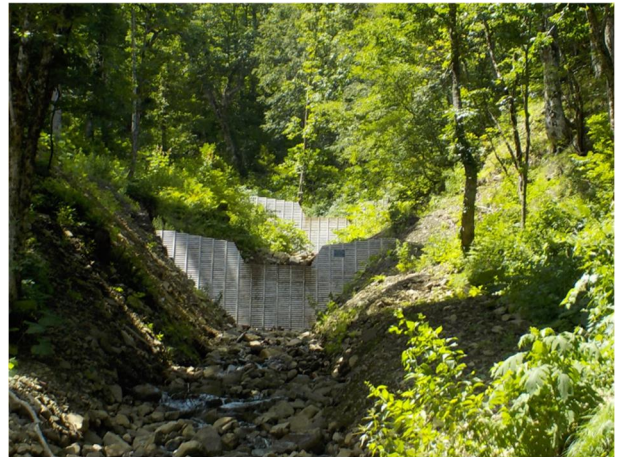
治山ダム (雄物川森林計画区)
