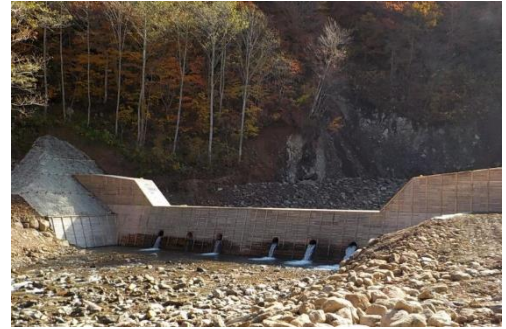
木材を利用した谷止工 (馬淵川上流森林計画区)
