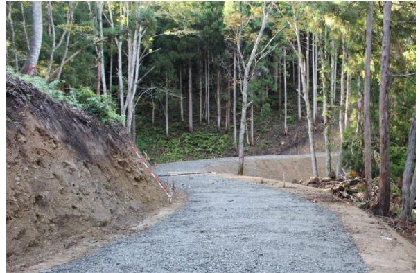
林業専用道の作設 (馬淵川上流森林計画区)
