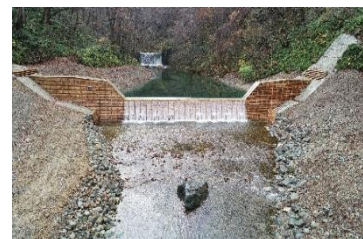
【荒沢第二治山工事（零石町）】
