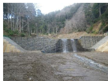
【鋼製枠床固工（外ヶ浜町）】
