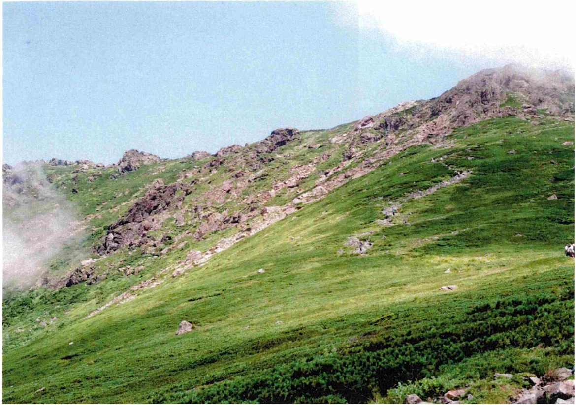
図 2 2019年8月現在の小田越登山道上部の崩壊の様子：C地点（標高1670m付近）からA・B地点方向を遠望
