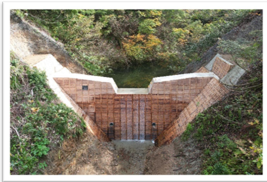
大清水沢地区谷止工
