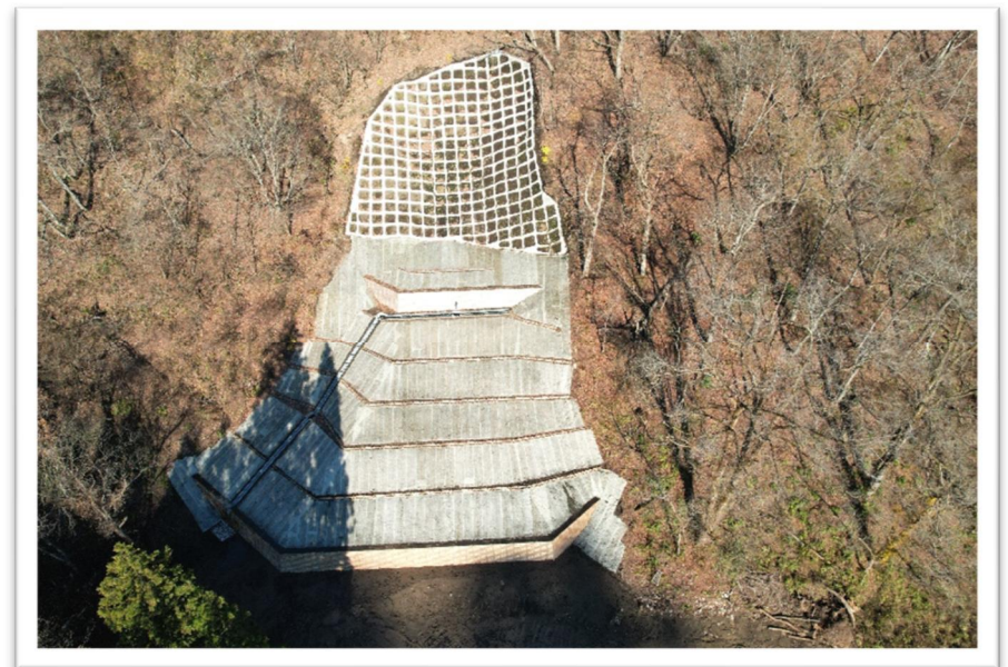
金目災害関連緊急治山工事
