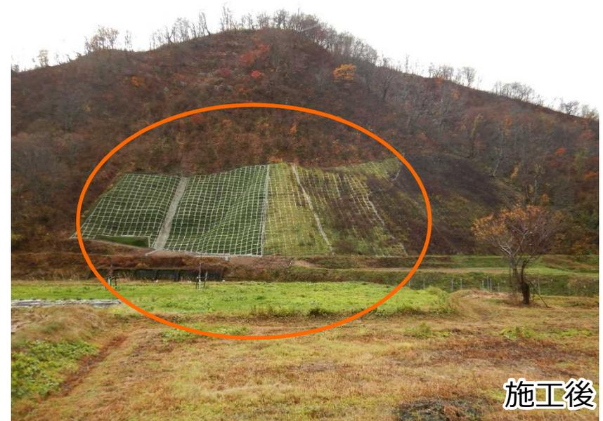
雪崩により山腹斜面が侵食され、直下の農地に土砂が流入する被害が発生したため、山腹斜面を固定する簡易法枠工を施工して、さらなる被害発生を防ぐ復旧対策を実施しました。
