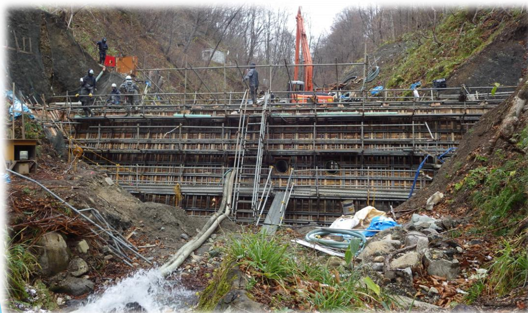
大猫沢における堤体工事
