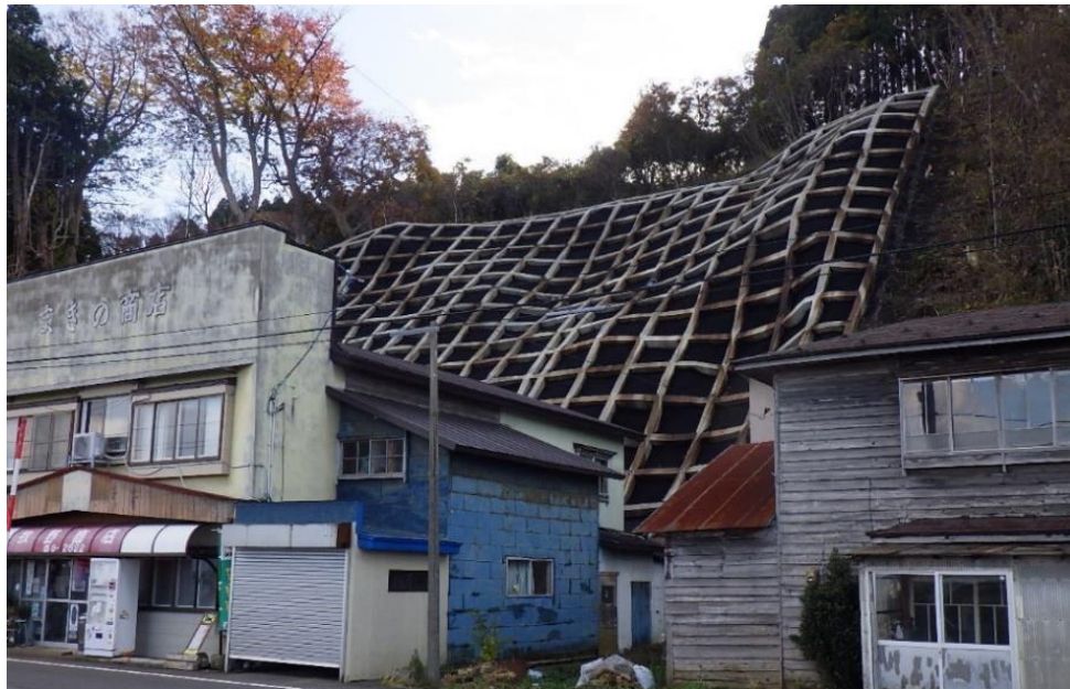
現場吹付法枠工（外ヶ浜町四枚橋地区）
