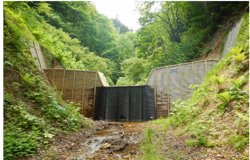
治山ダム工（外ヶ浜町平舘地区）
