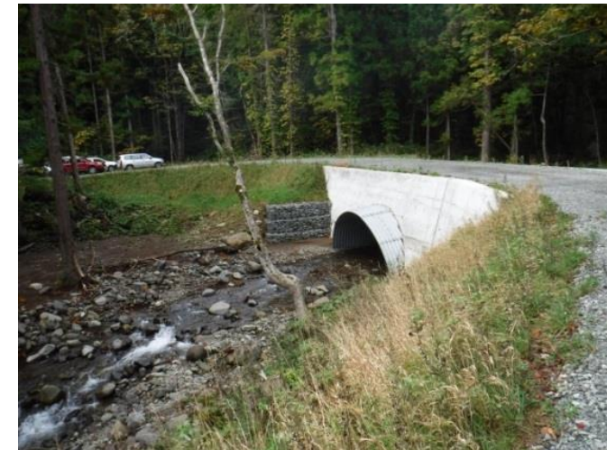
コルゲートアーチの施工箇所 （六ヶ所村）
