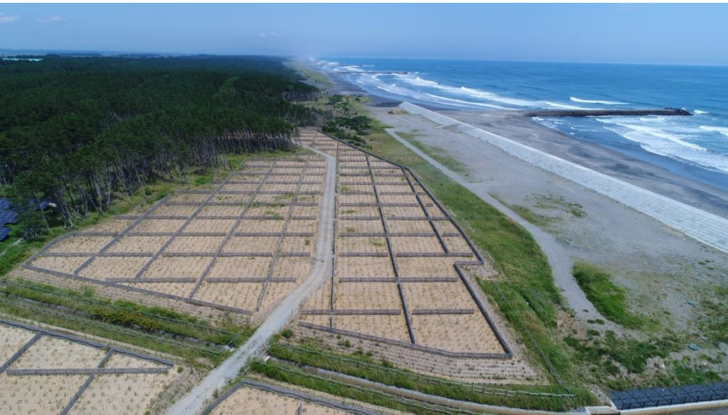
海岸防災林の機能回復のための静砂工等(三沢市)
