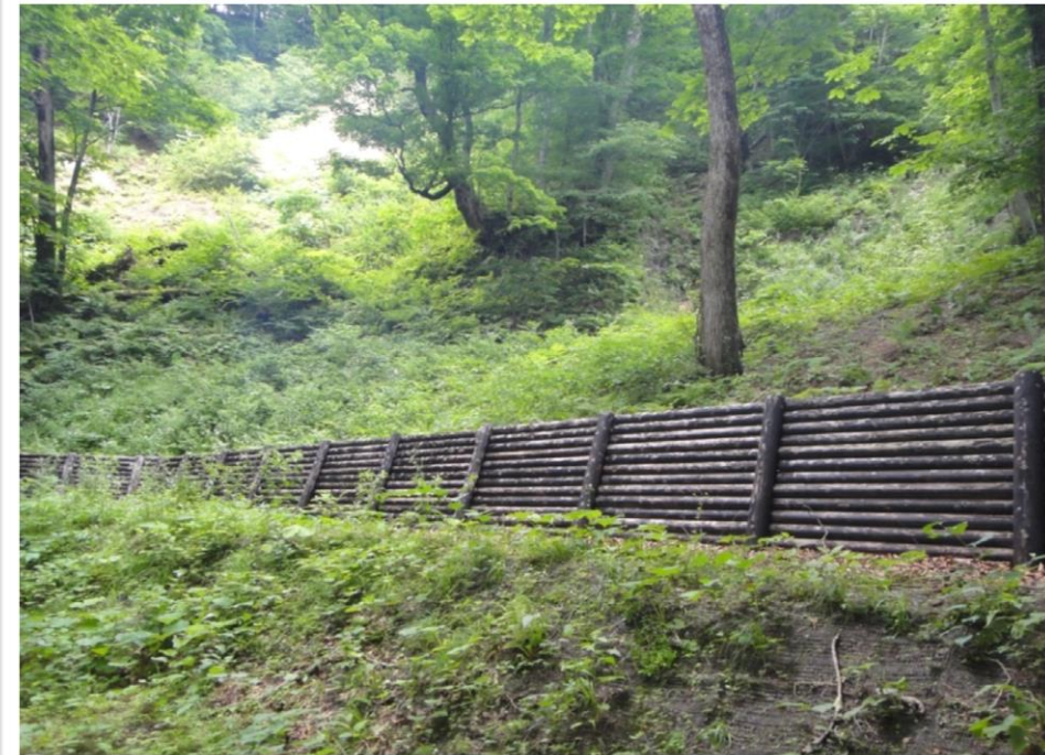
景観に配慮した鋼製砕土留工(十和田市)
