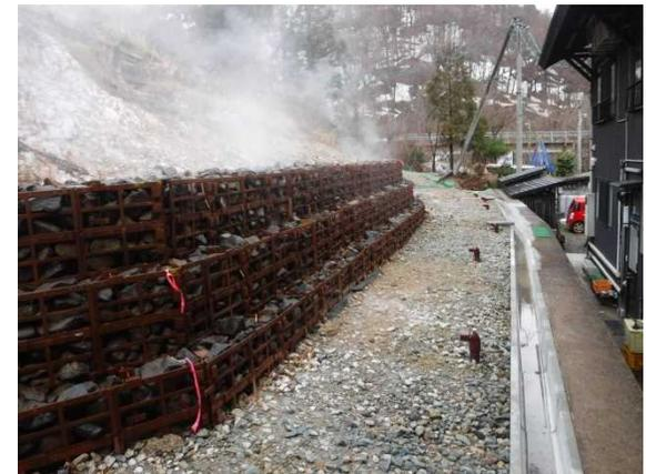
铸铁製組立枠の土留工
