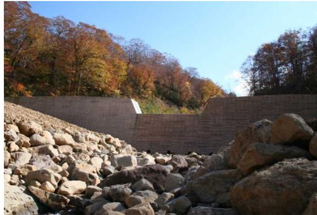
木製残存型枠を使用した治山ダム
