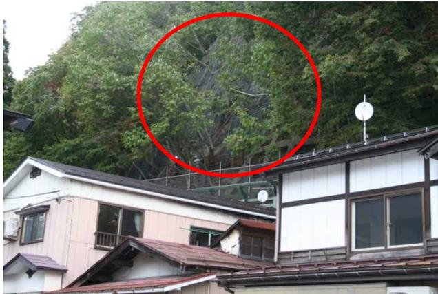
落石防止のため施工したネット工
