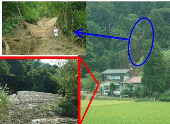
土砂撤去・大型土のう積等の応急対策
