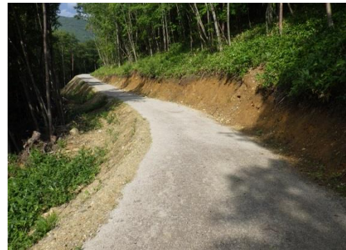
鉄鋼スラグによる新設林道
