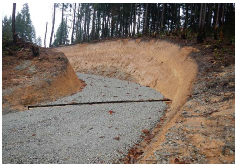
竜渡沢林業専用道新設工事
