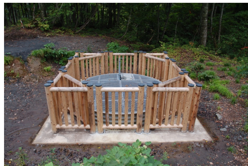
湯殿山地区治山工事
