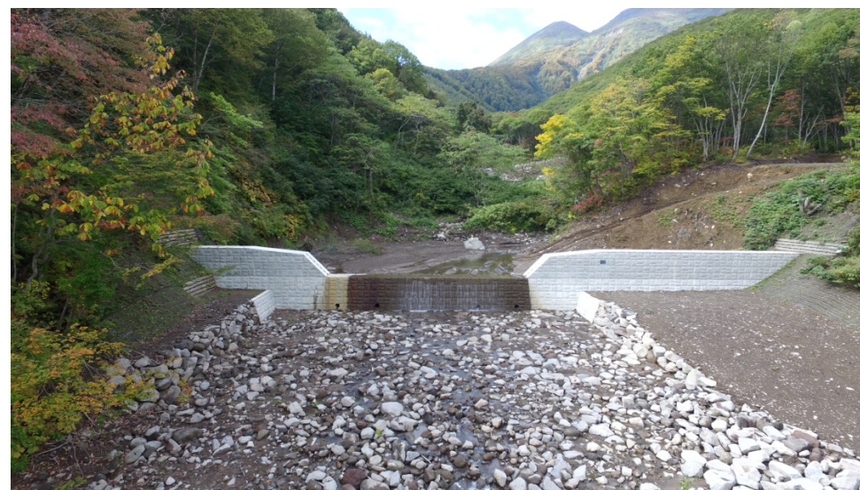
後長根沢床固工
