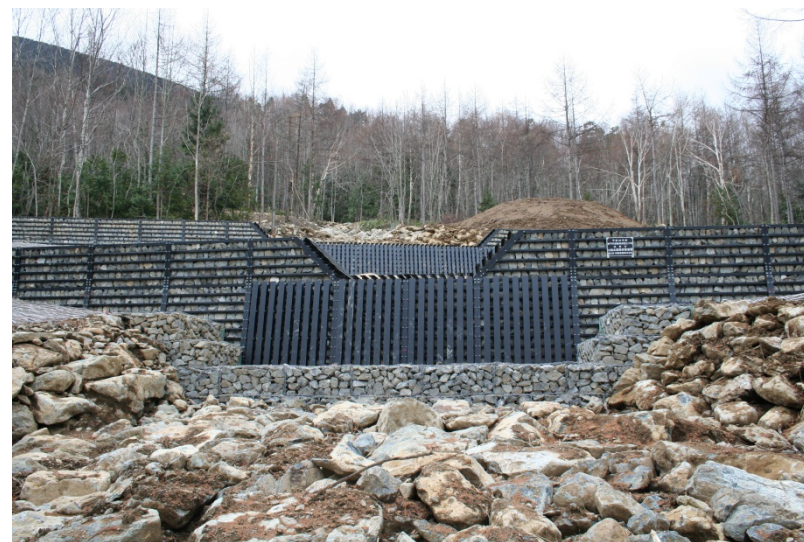
金平沢治山工事(鋼製ダム)
