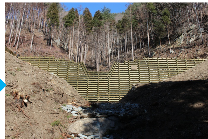
さらに下流への土砂流出を防ぐため、 治山工事を実施
