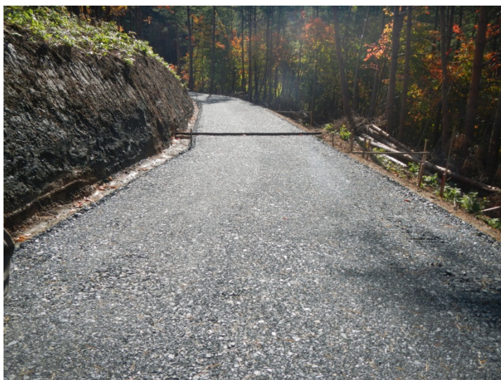
水無沢林道新設工事
