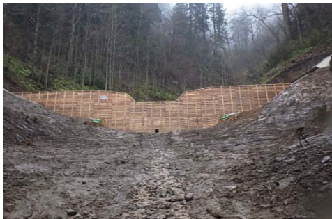
間伐材を利用した治山ダムの施工状況（大間町【大平沢】）
