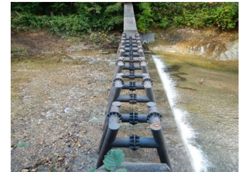
流木取り除き後
