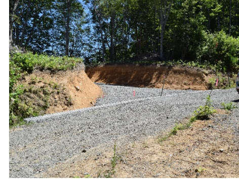
森林整備推進協定により完成した 民有林林道入口 (風間浦村) (手前の林道は国有林)
