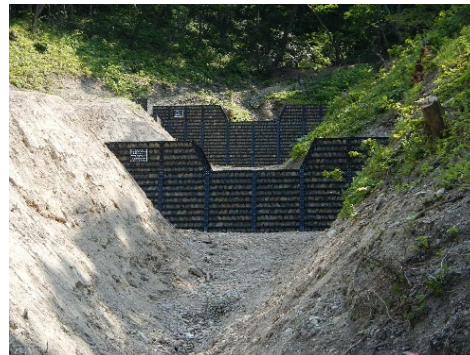
施工後(鋼製枠ダム)
