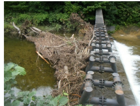
流木捕捉状況
