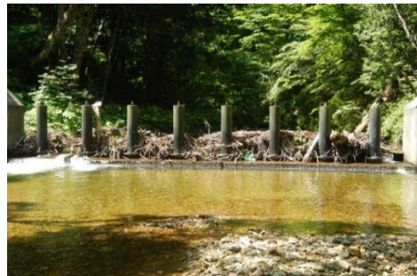
スリットダムによる流木の補足状況（むつ市大畑町【大畑川】）
