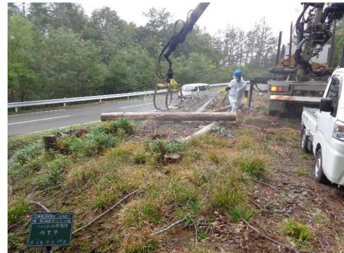
スギ丸太への防腐剤散布状況
