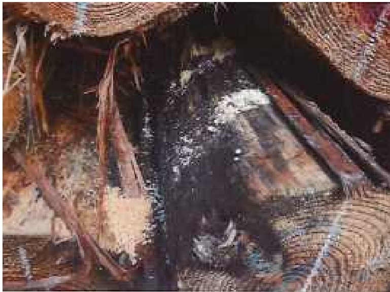
スギ丸太の腐植状況
