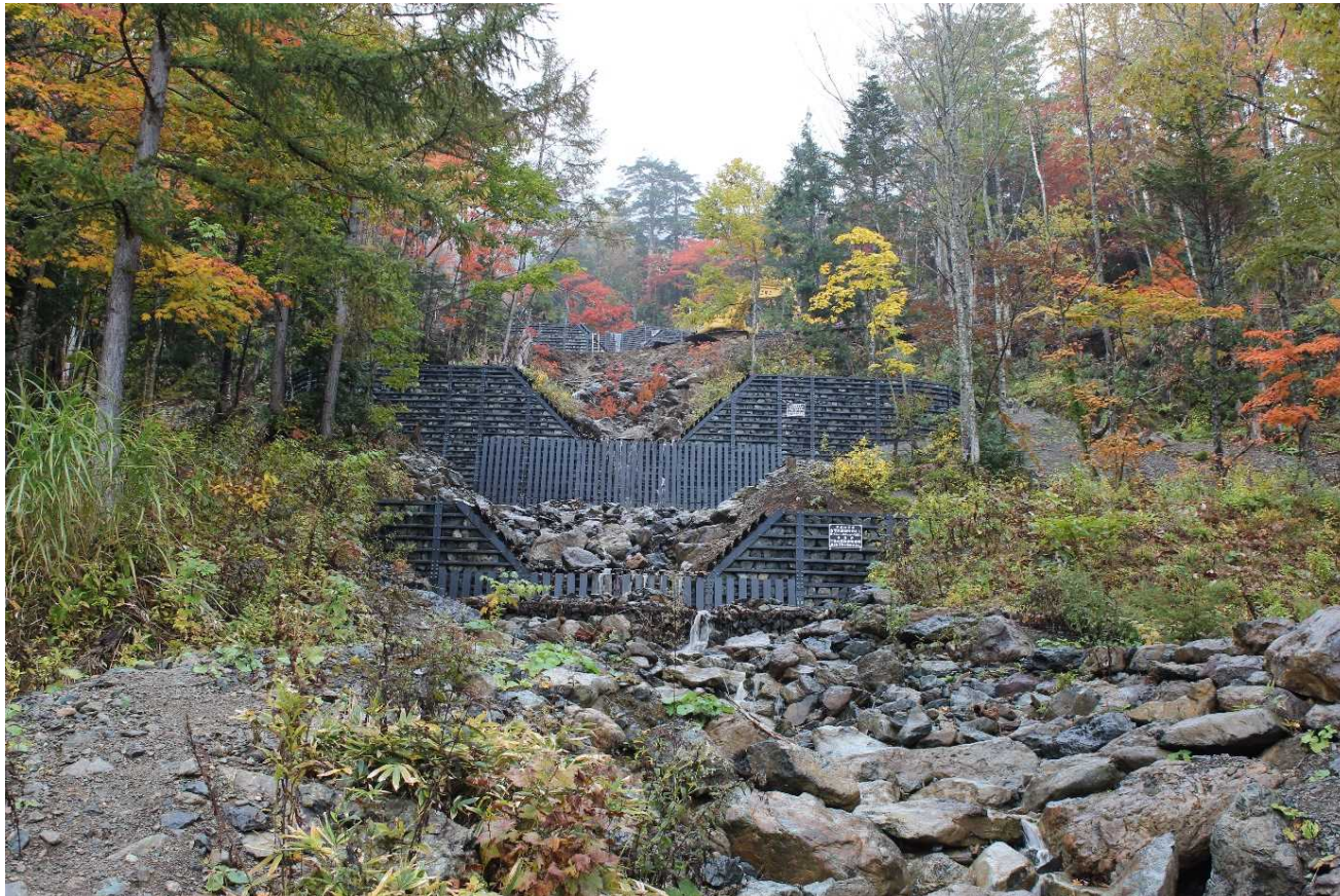
金平沢治山工事 (宮古市門馬山国有林)
