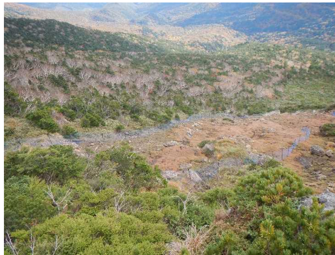
早池峰山国有林にニホンジカ対策の防鹿柵(植生保護柵)を設置
