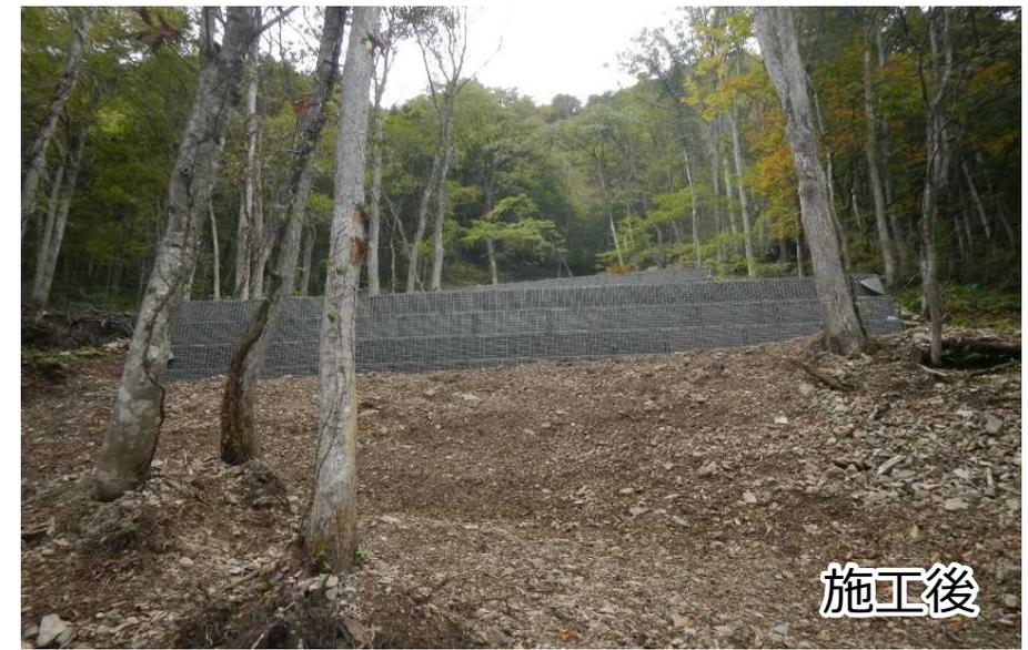
豪雨により山腹から直下の市道に土砂が流入する被害が発生したため、土砂の流出を防止する鋼製組立網土留めを施工して、さらなる被害発生を防ぐ復旧対策を実施しました。
