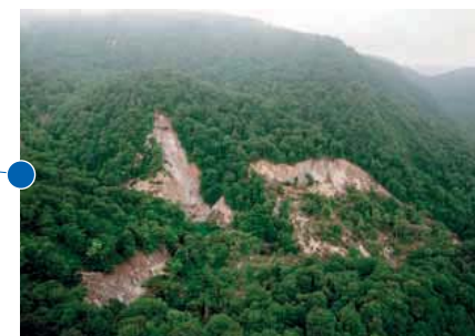
一ツ石沢上流 山腹崩壊による河道閉塞状況
