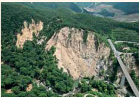
岩盤崩壊 胆沢川流域
