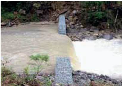
尿前沢 溪間工 谷止工（カゴ枠工）
