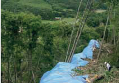
市野々原 遮水シートによる二次災害防止措置
