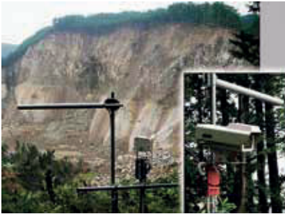
荒砥沢地すべり 監視カメラ設置
