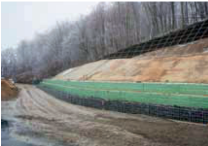
耕英地区 山腹工（土留工・法枠工）
