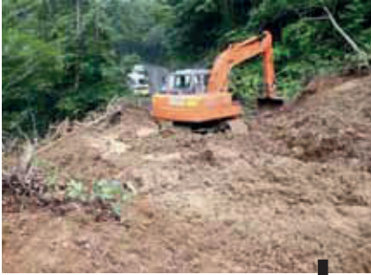
東桂沢国有林林道 迂回路確保のため崩落土砂を除去
