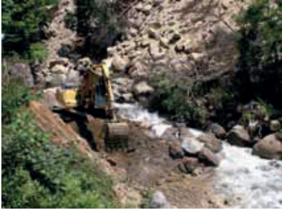
尿前沢 無人バックホウによる河道開削工事
