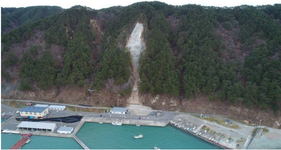
工事名：久喜地区災害関連緊急治山工事
