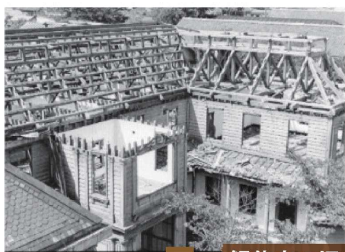
解体中の旧庁舎
