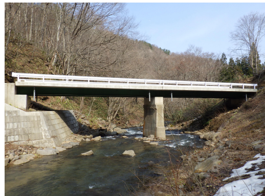
工事名：下黒滝川橋改良工事
