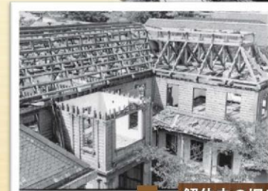
解体中の旧庁舎
