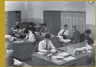
竣工当時の執務室
