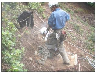
雪崩柵のためのアンカー(引 張材)設置のための削孔作業 状況
