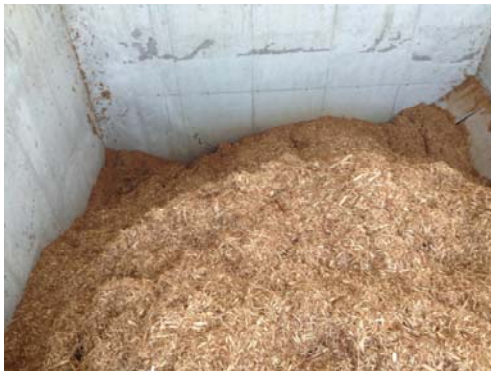
木質チップが自動でボイラーへ
