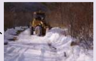
林道の除雪(遠野支署管内)
