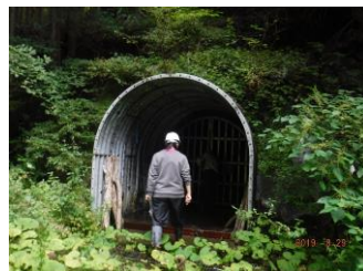
排水トンネル見学(櫻尾地区)
